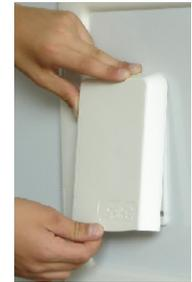
Abdeckung oben aufsetzen unten etwas nach vorne ziehen. Abdeckung von oben nach unten schieben und einrasten. Bei Andrücken dieser Schrauben einsetzen und leicht anziehen
